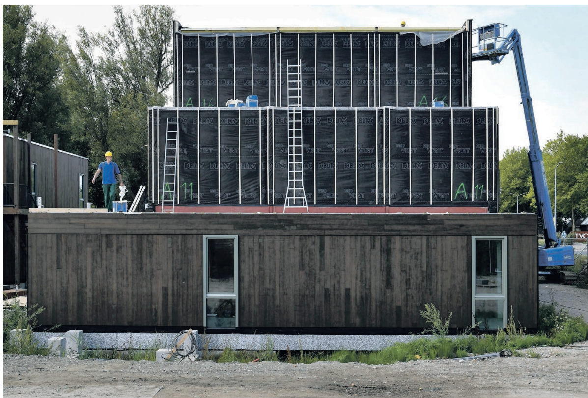
Flexibele wooneenheden worden gestapeld om gezamenlijk het complex Oostertuin te vormen in Nieuw-Vennep, in de gemeente Haarlemmermeer.
